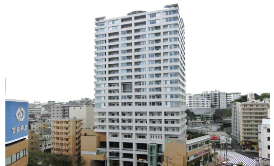
▲ 神奈川・日ノ出町駅前A地区市街地再開発事業 (2015年竣工)
