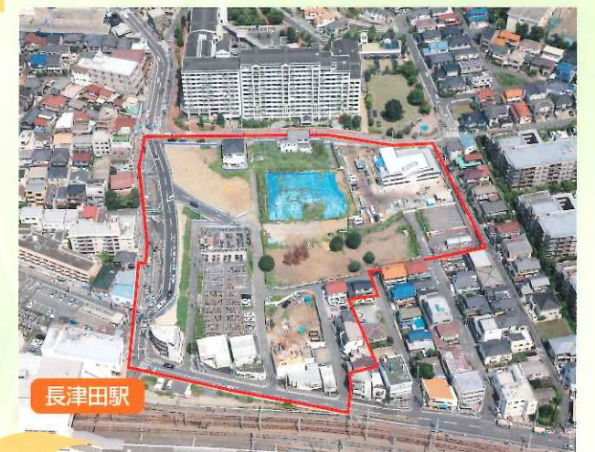
解体工事・公共駐輪場工事中(平成22年8月)
